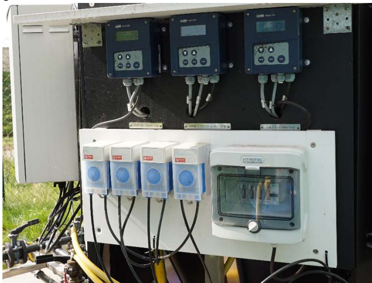
Abbildung 12 Pumpen (unten rechts) und Zeitschaltung (unten links) zur täglichen Nachdosierung der Nährstoffe
